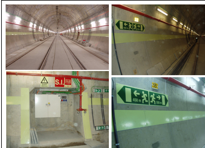
Tunnel ferroviaire de Rossio – Portugal 2008 2 tubes de 2600 mètres.
