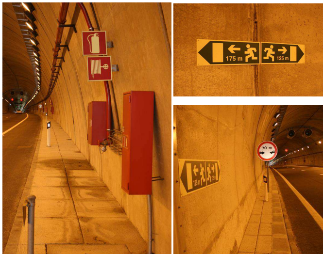
Tunnel routier A27 Viana de Castelo - Ponte de Lima - Portugal 2008
