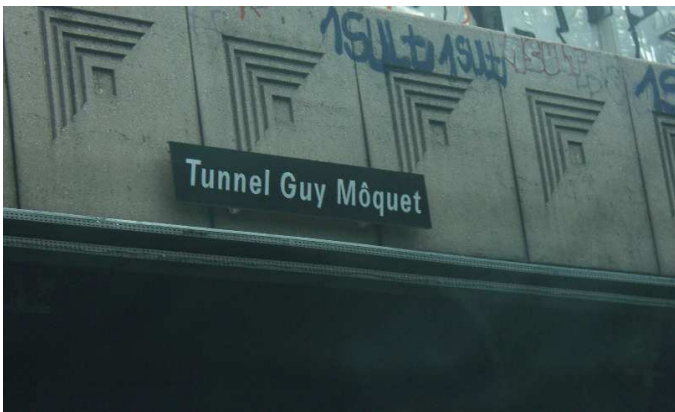
Tunnels Guy Môquet et du Moulin (Thiais), A86 - France 2016 2 tubes de 650m et 2 tubes de 1476m
