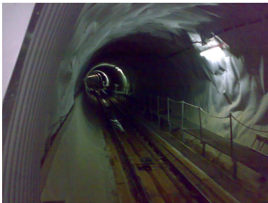
Tunnel du funiculaire de Bulnes – Espagne 2008 Tunnel de 2000 mètres avec un dénivelé de 18%.
