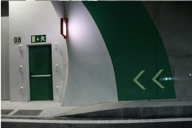
Tunnel de Marão Infraestruturas de Portugal A4, Serra do Marão – Portugal 2016 2 tubes de 5665m
