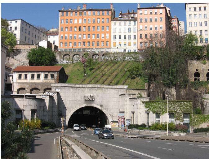
Tunnel routier de la Croix-Rousse à Lyon - France 2013. 1 tube neuf et 1 rénové d'une longueur de 1782m chacun.
